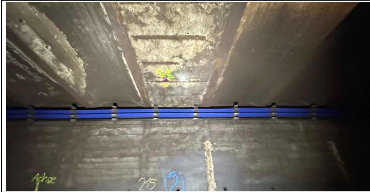
Anlage RWD Bild 3: Übersicht – Blick Richtung Tunnelaußenwand (Gleisseite Richtung Feldstraße), untersuchter Träger im Bereich in welchem die Kappendecke aussetzt, beide Trägerarten wie auch Stütze in der Wand mit Abrostungserscheinungen
