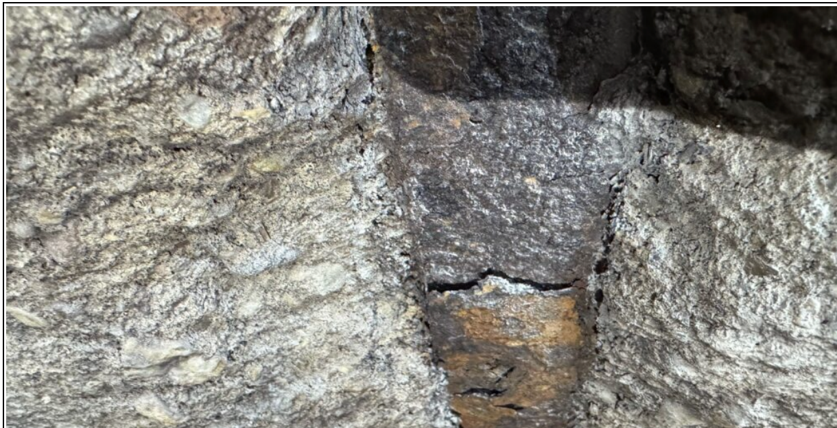
Anlage RWD Bild 4: Detailaufnahme – Flanschunterseite flächig mit Korrosion und sichtbarem Querschnittsverlust in Form von Blattrost,
